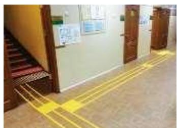
Специальные объемные тактильные плитки и другие варианты напольных тактильных покрытий (например, встраиваемые направляющие полосы и биты) формируют рисунок, позволяющий незрячим людям получать информацию о безопасном пути движения (направления движения, повороты) и о наличии препятствий пути движения (пороги, перекрестки, ступени, лестницы, или колонны, двери, пешеходные подземные переходы).
